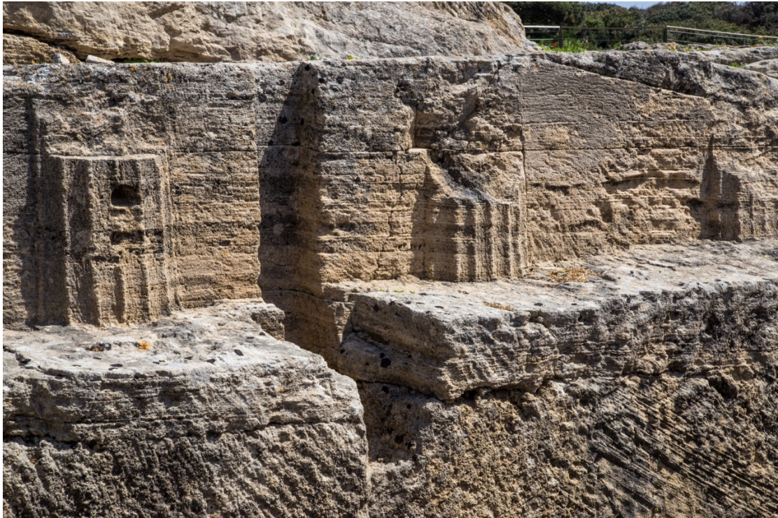
Fig. 22 - Tempio delle semicolonne: particolare della decorazione di un lato lungo (foto di Unicity S.p.A.)
