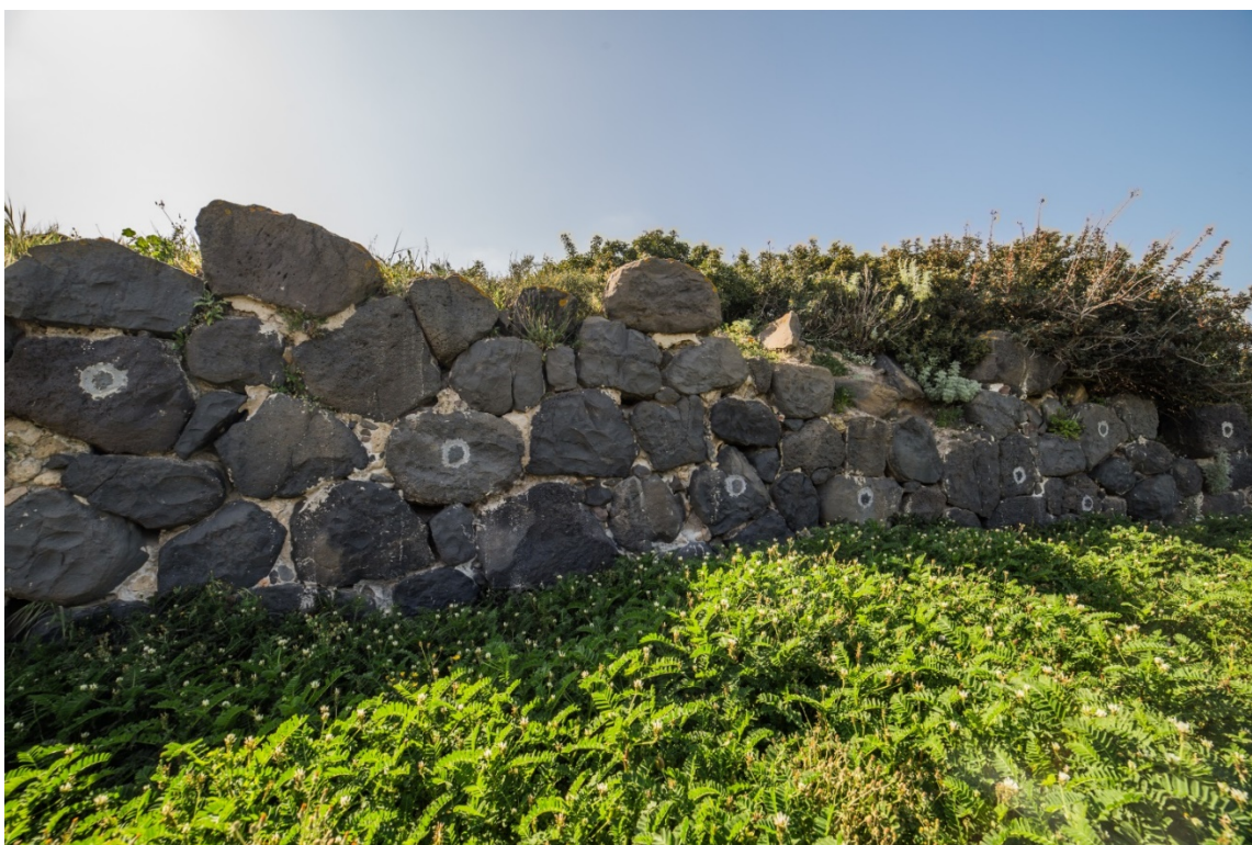
Fig. 11 - Il muro di controscarpa del fossato (foto di Unicity S.p.A.)
