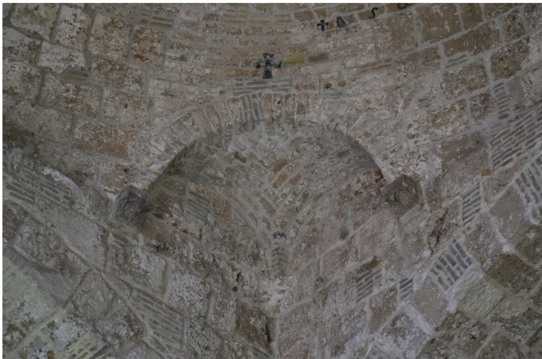
Fig. 2 - Détail de la demi-voûte d'arête de raccord entre la coupole circulaire et le tambour carré (photo Unicity S.p.A.)
