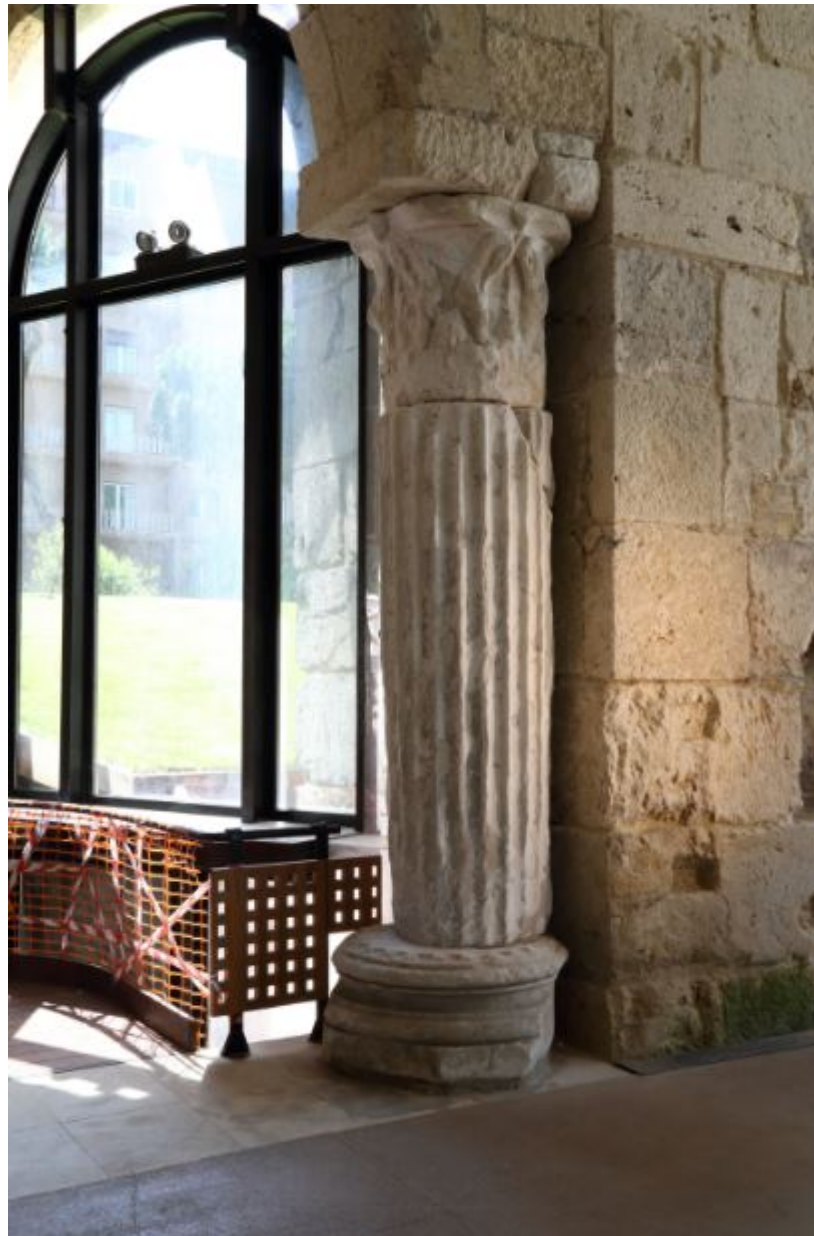
Fig. 2 - Éléments architecturaux de réutilisation (base, colonne, chapiteau) dans le mur de séparation de la nef de droite du bras oriental (photo Unicity S.p.A.).
