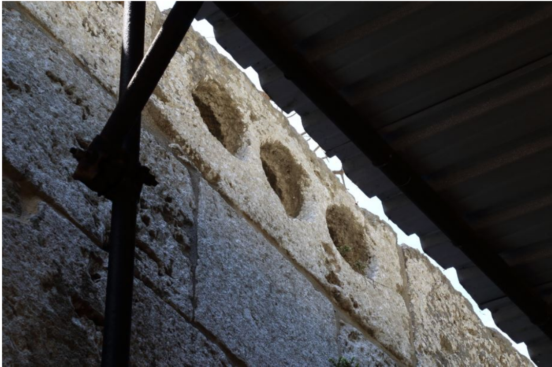
Fig. 2 - Claveau avec cavités pour les urnes funéraires réutilisé à l'extérieur du mur nord du bras occidental (photo Unicity S.p.A.).
