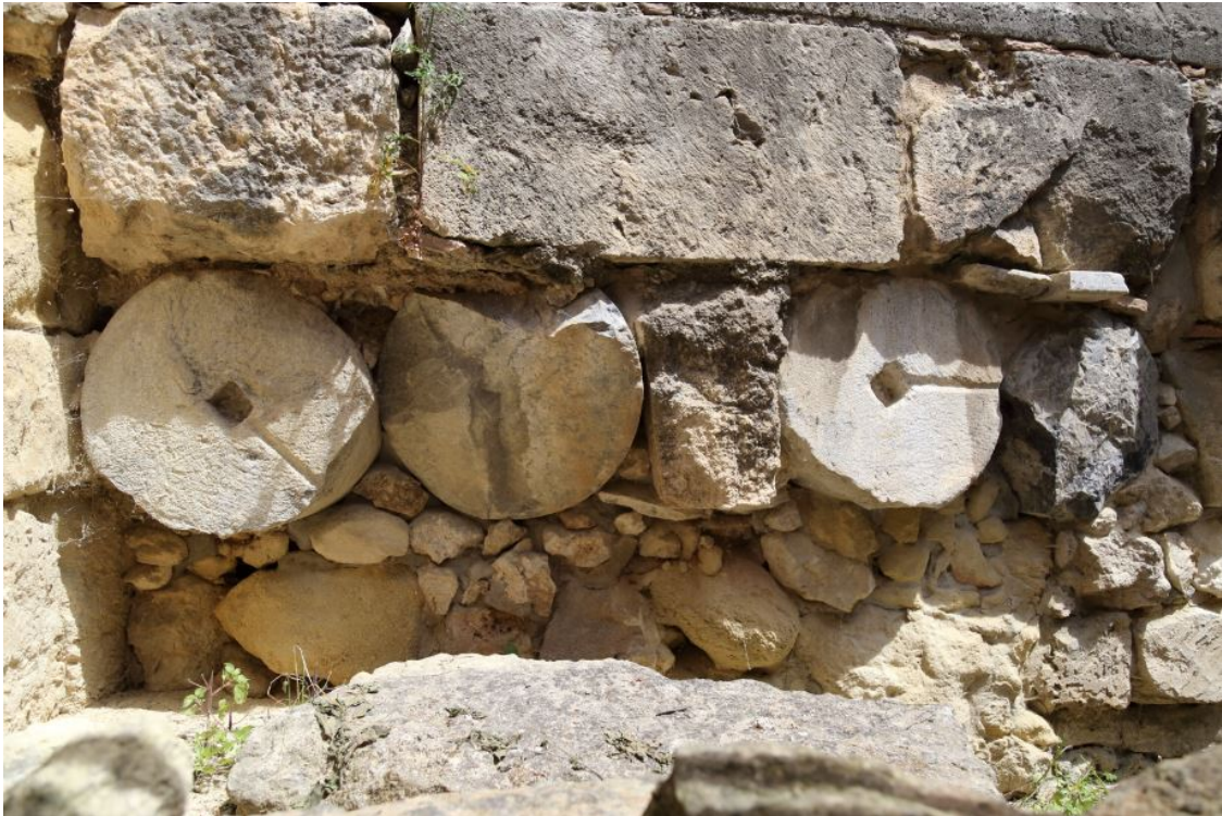
Fig. 4 - Éléments de réutilisation à la base de l'abside (photo Unicity S.p.A.).
