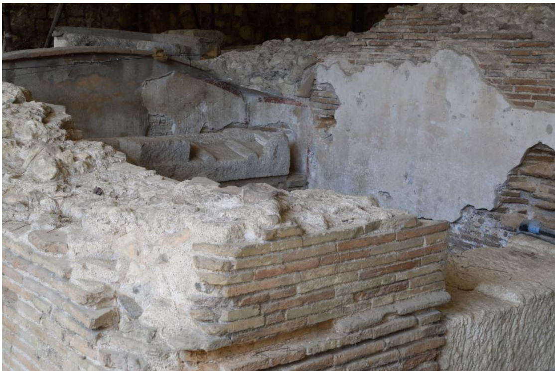
Fig. 2 - Mausolée : détail de la technique de construction en briques (photo Unicity S.p.A.).
