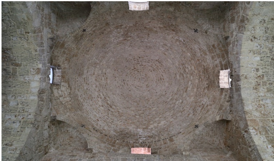
Fig. 8 - La coupole avec les pendentifs vus de l'intérieur (photo Unicity S.p.A.).
