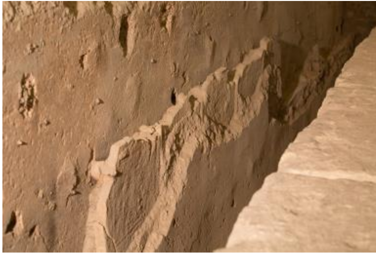
Fig. 6 - Tuiles hamatae à l'arrière de la colonnade (photo Unicity S.p.A.).
