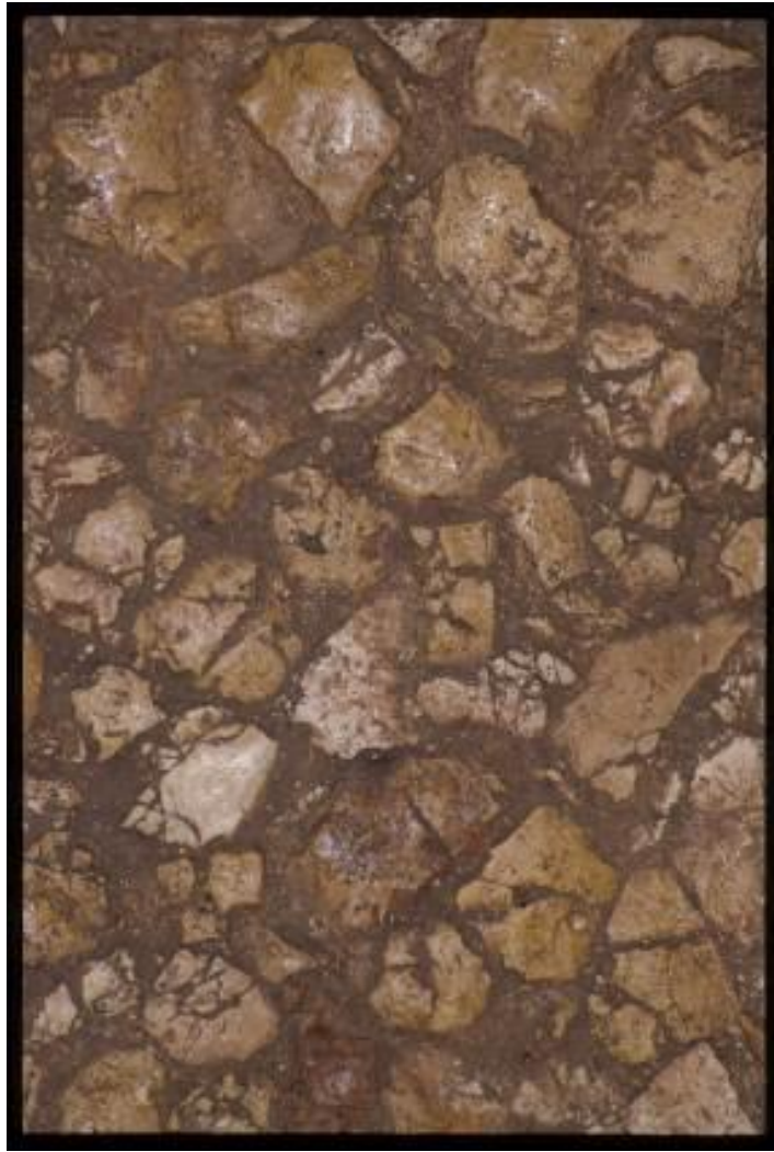
Fig. 2 - Détail des éléments en pietraforte mélangés avec des éléments en marbre (photo AFS).
