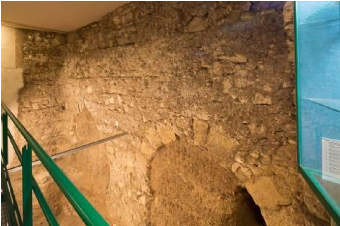
Fig. 2 - Mur oblique et cloison tangente avec arcades inférieures visibles dans la zone archéologique (photo Unicity S.p.A.).
