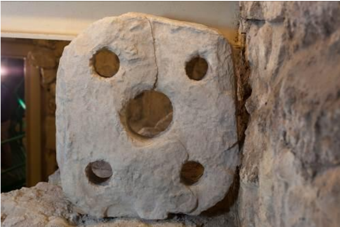
Fig. 1 - Cagliari, Sant'Eulalia : claveau percé (photo Unicity S.p.A.).
