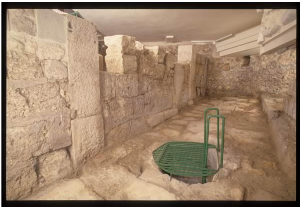
Fig. 3 - Mur à chaînage délimitant le côté gauche de la route pavée (photo AFS).
