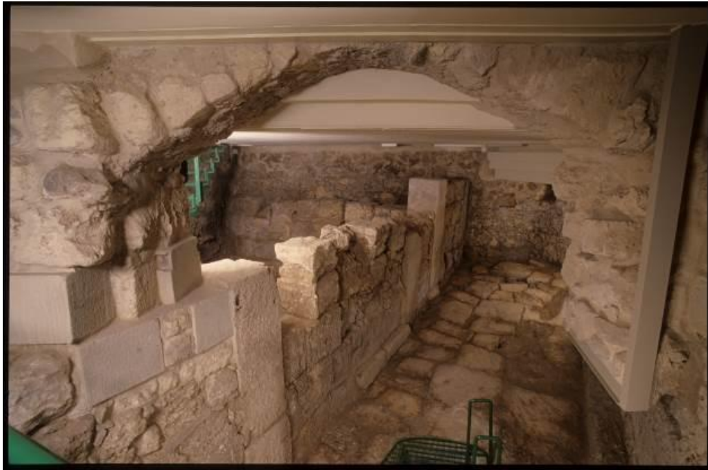
Fig. 2 - Mur à chaînage fermant l'habitation au nord-ouest en en oblitérant l'accès à la route. En haut, arc du XVIII e siècle (photo AFS).
