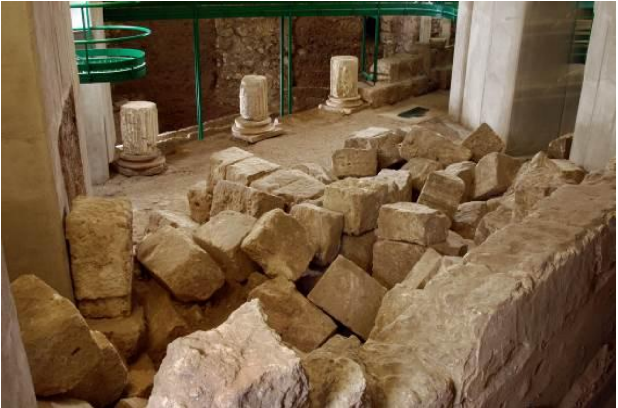
Fig. 2 - Le deuxième effondrement vu depuis l'arrière des arcades (photo AFS).
