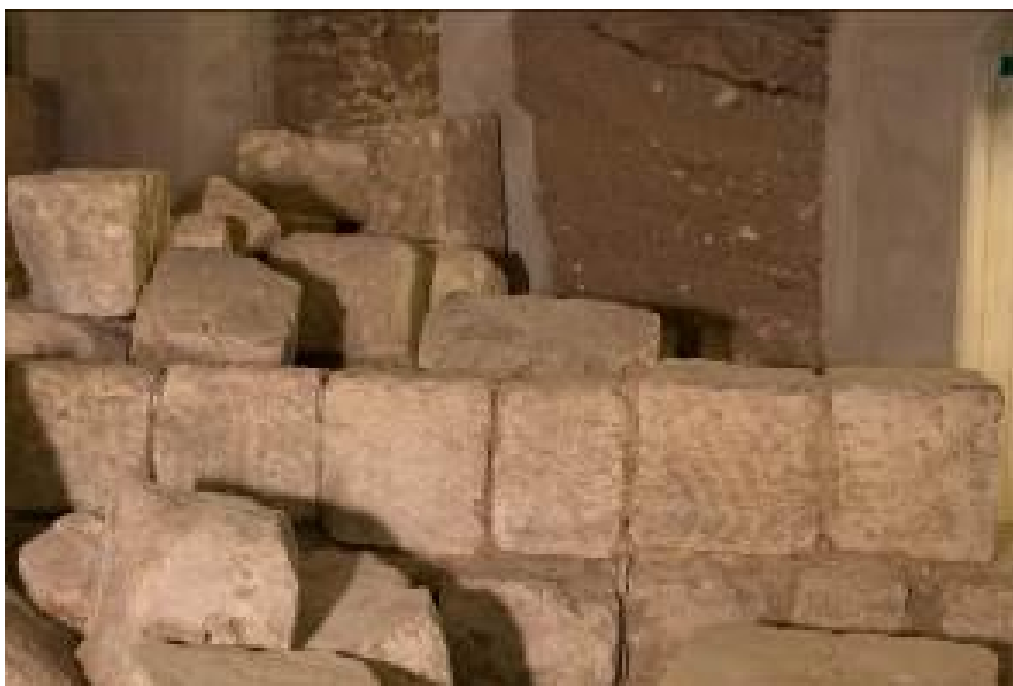
Fig. 1 - Mur transversal constitué par des blocs de réutilisation récupérés après le premier effondrement et construit sur un éboulement sous les arcades (photo de R. Martorelli).
