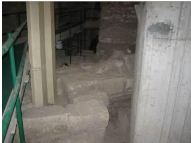
Fig. 3 - Premier effondrement (photo R. MARTORELLI).
