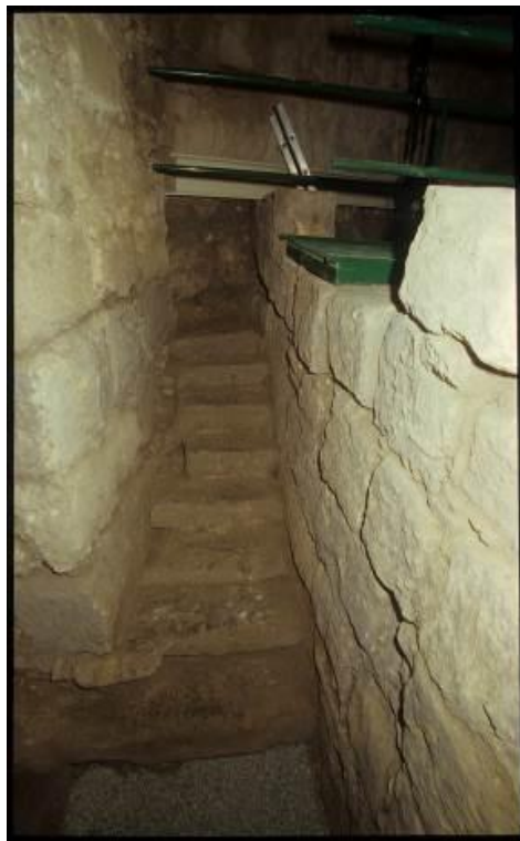
Fig. 1 - Habitation au nord-est : rampe d'escalier reliant le niveau supérieur (photo AFS).
