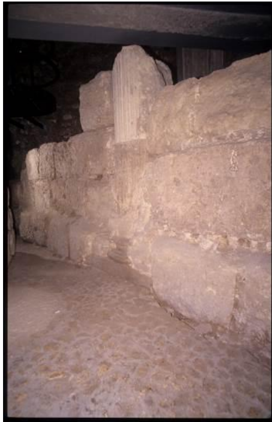
Fig. 3 - Colonne revêtue de blocs façonnés (photo AFS).
