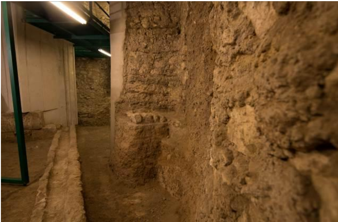
Fig. 3 - Rigole contiguë aux bâtiments de l'église (photo Unicity S.p.A.).
