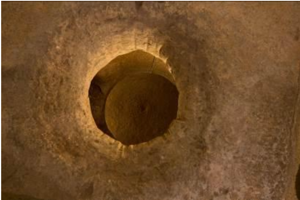
Fig. 1 - Citerne-bouteille : goulot (photo Unicity S.p.A.).
