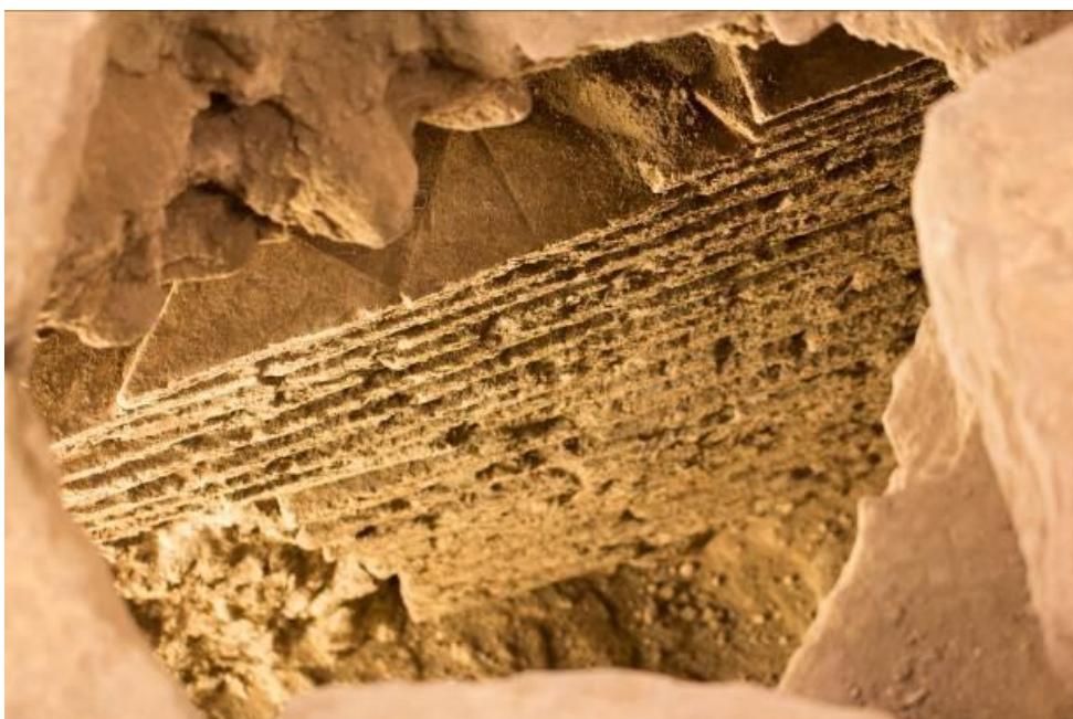
Fig. 2 - Revêtement interne du conduit d'égout (photo Unicity S.p.A.).
