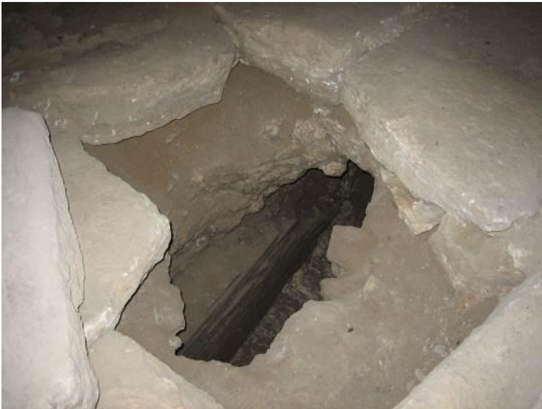
Fig. 1 - Conduit d'égout durant les fouilles (photo Unicity S.p.A.).
