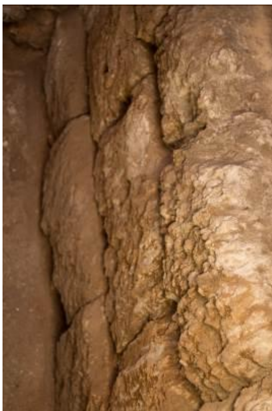
Fig. 2 - Blocs à bossage recouvrant le podium du sanctuaire (photo Unicity S.p.A.)
