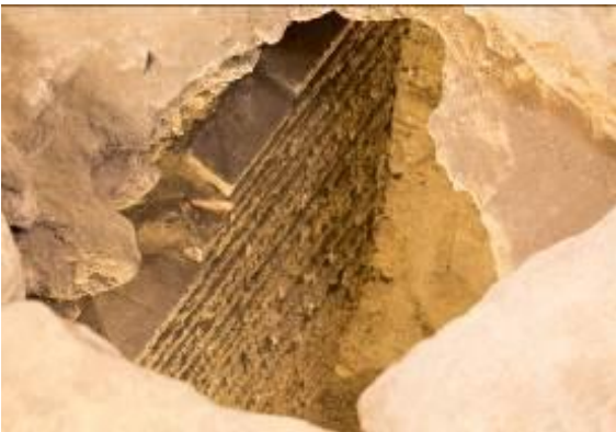
Fig. 2 - Mur à l'intérieur du conduit d'égout en terre cuite (photo Unicity S.p.A.).
