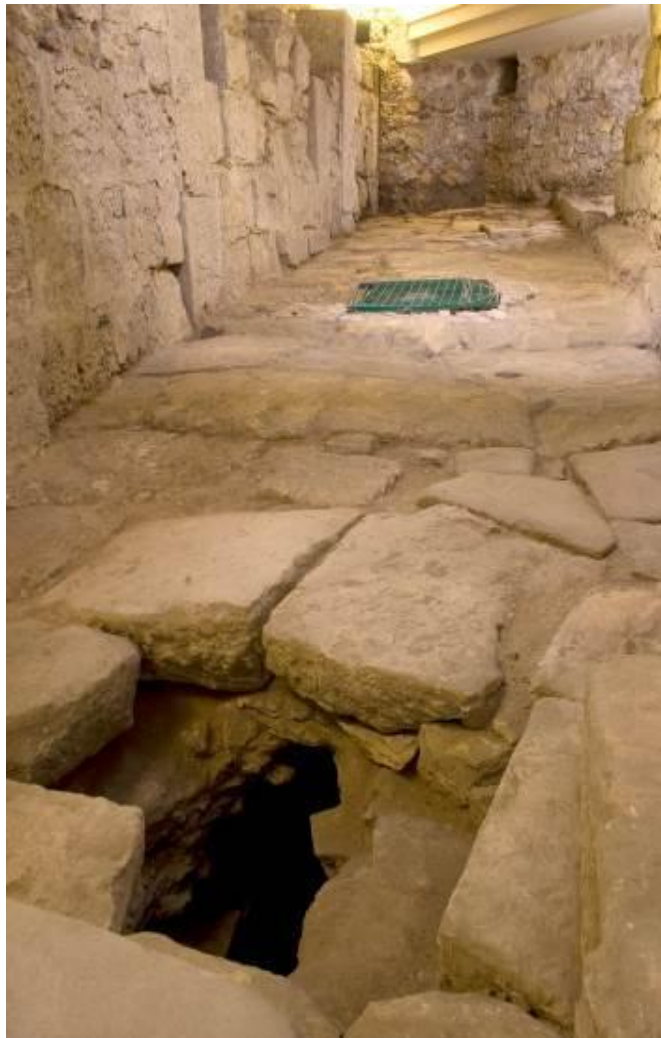
Fig. 1 - Puisard d'inspection de l'égout, ouvert sur la route pavée (photo Unicity S.p.A.).
