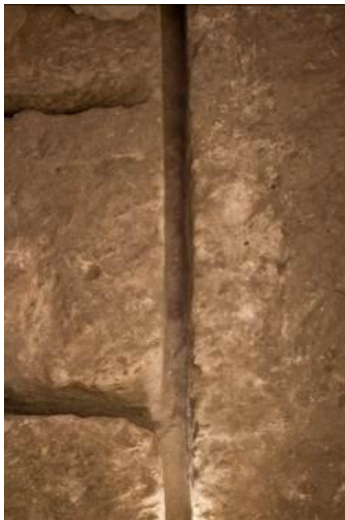
Fig. 4 - Détail de quelques blocs prêts (photo Unicity S.p.A.).
