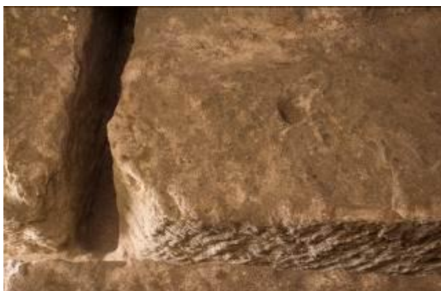
Fig. 3 - Détail de la coupe entre deux blocs calcaires pour l'extraction (photo Unicity S.p.A.).
