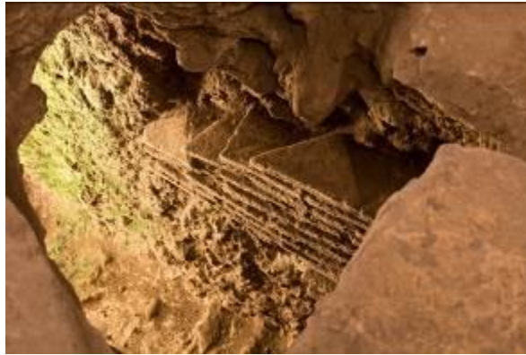
Fig. 3 - Segment du réseau d'égout en partie creusé dans la roche, en partie construit avec des éléments en terre cuite (photo Unicity S.p.A.).
