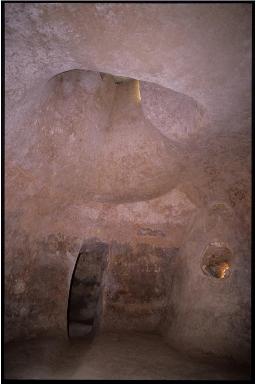
Fig. 5 - Citerne placée sous la salle concernée par la surélévation du plancher (photo AFS).
