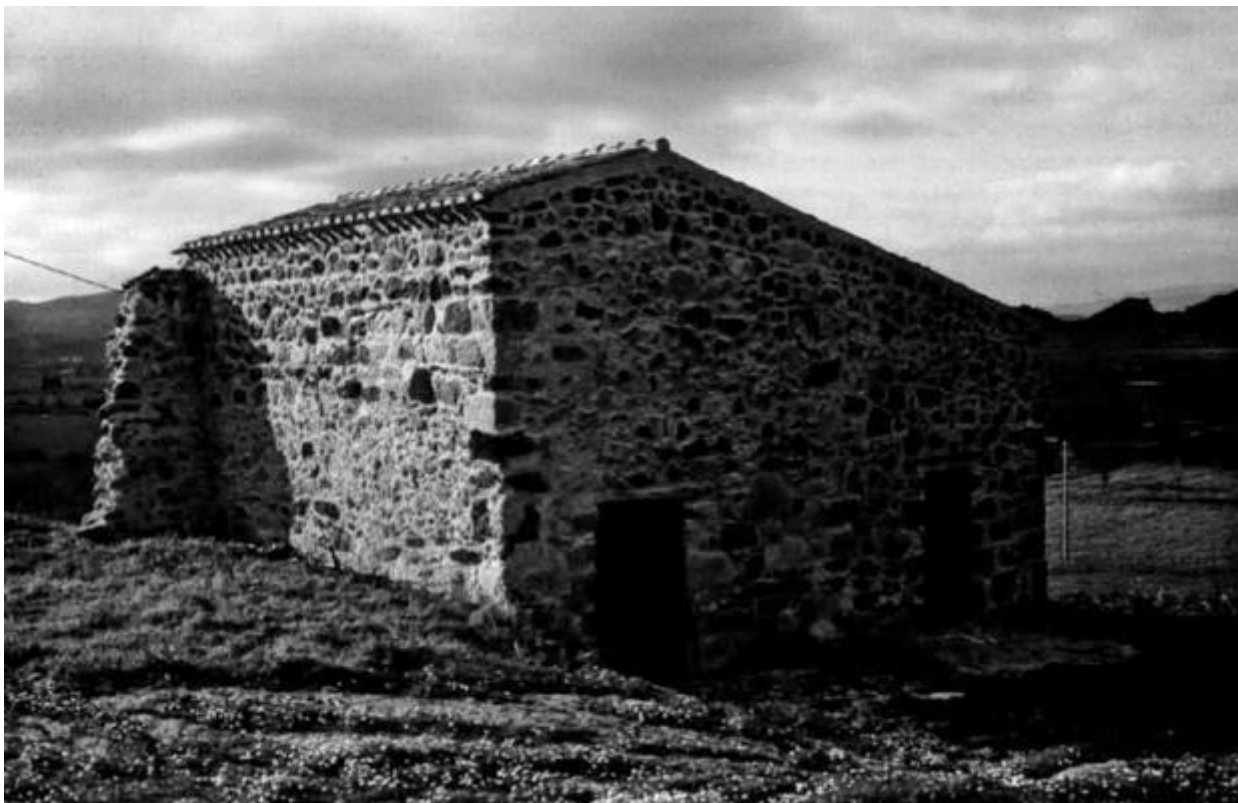
Fig. 2 - Le bâtiment de Sas Presones de Rebeccu après la restauration (Mastino, Ruggeri 2009, p. 556, fig. 2).
