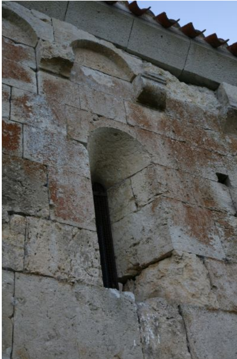
Fig. 5 - Les petits arcs en demi-cercle et la fenêtre à une seule ouverture (photo de M.G. Arru).
