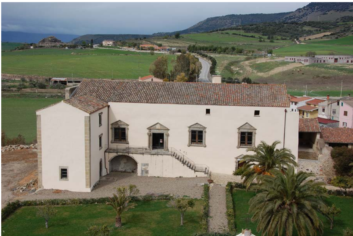
Fig. 2 - Vue d'ensemble du palais Zapata ( http://www.comune.barumini.vs.it/export/sites/barumini/Amministrazione/immagini/102.jpg ).
