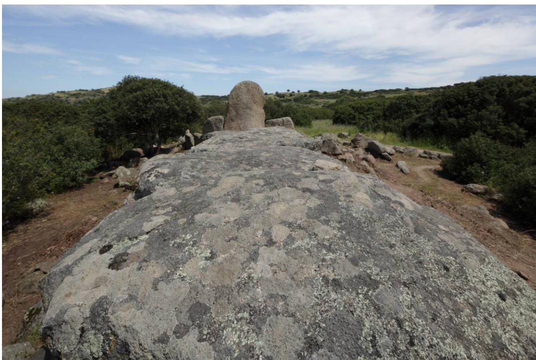
Fig. 9 - Détail des grandes plaques granitiques de la couverture (photo Unicity S.p.A.).
