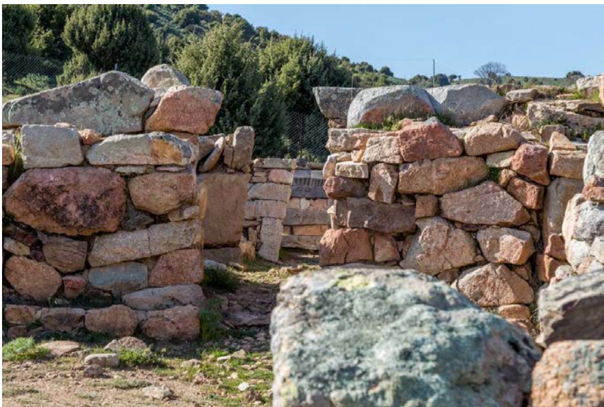
Fig. 3 - Vue générale de l'intérieur du temple. Au fond, détail de la reconstruction de l'autel-foyer présent dans la salle en abside (photo Unicity S.p.A.).
