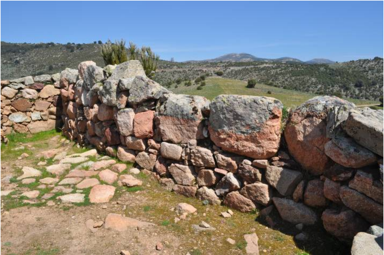
Fig. 2 - Intérieur du mégaron 3, dallage et maçonnerie (photo de E. Atzeni).
