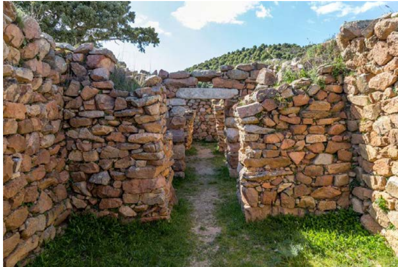
Fig. 2 - Intérieur du temple en mégaron 1. Au fond, la salle D (photo Unicity S.p.A.).
