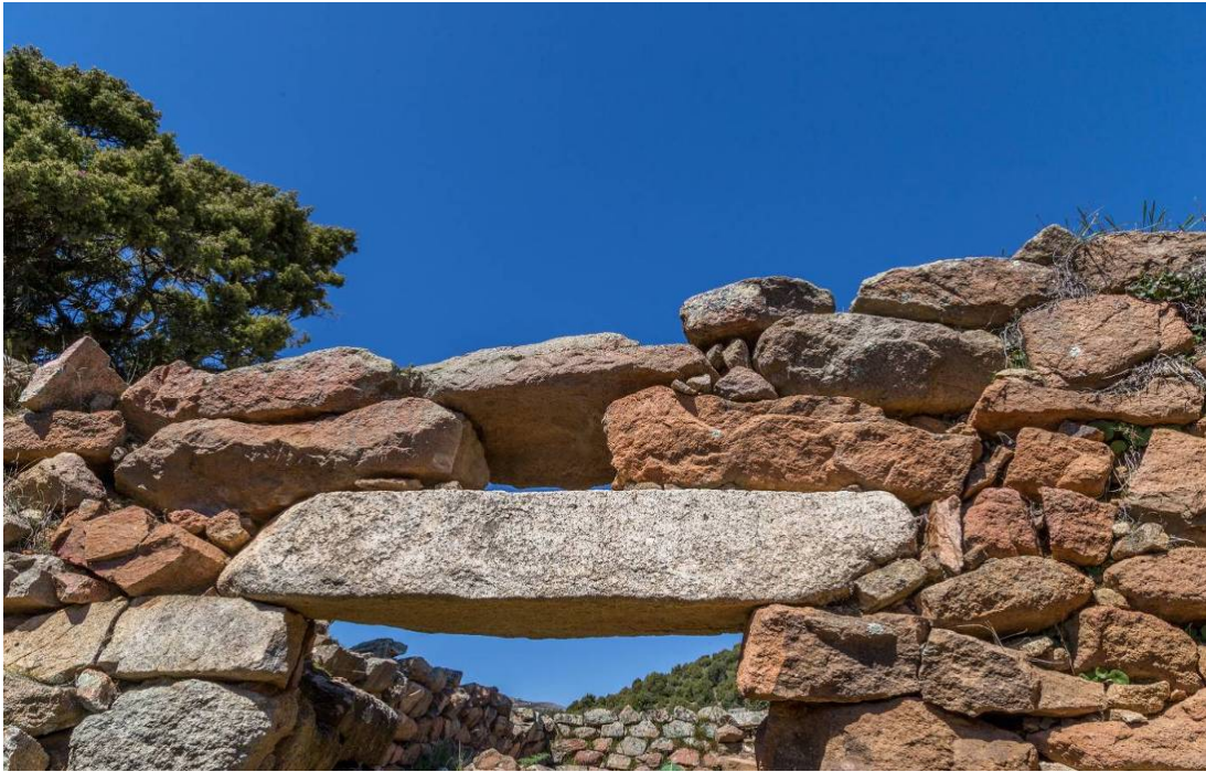
Fig. 2 - Entrée architravée de la salle C du temple en mégaron 1 (photo Unicity S.p.A.).
