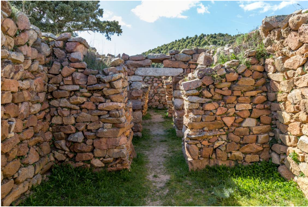
Fig. 3 - Détail du couloir d'accès à la salle A (photo Unicity S.p.A.).
