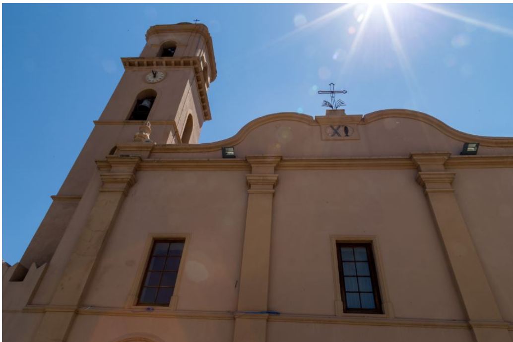
Fig. 1 - Détail de la façade principale de l'église S. Andrea (photo Unicity S.p.A.).
