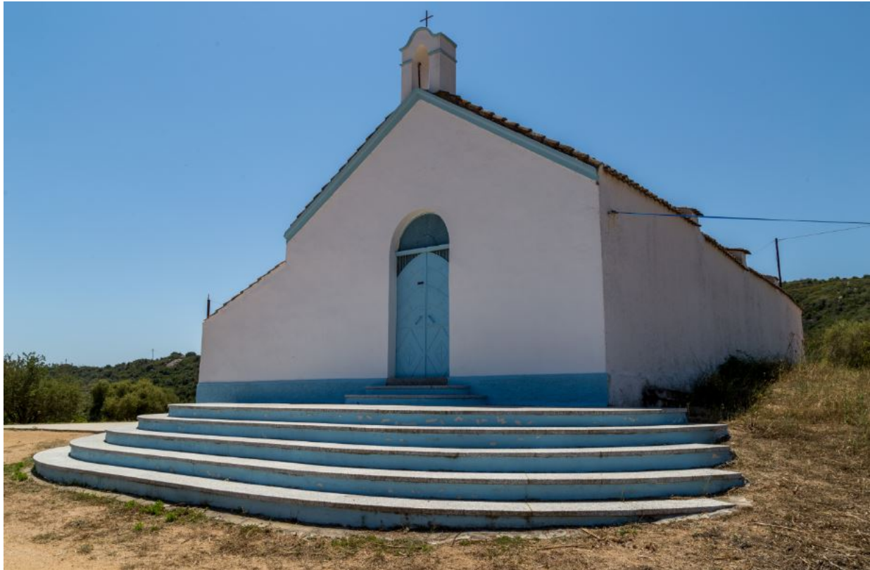
Fig. 2 - La façade principale de l'église San Salvatore (photo Unicity S.p.A.).
