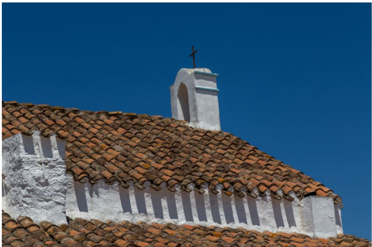
Fig. 3 - Détail du toit et du clocher-mur (photo Unicity S.p.A.).
