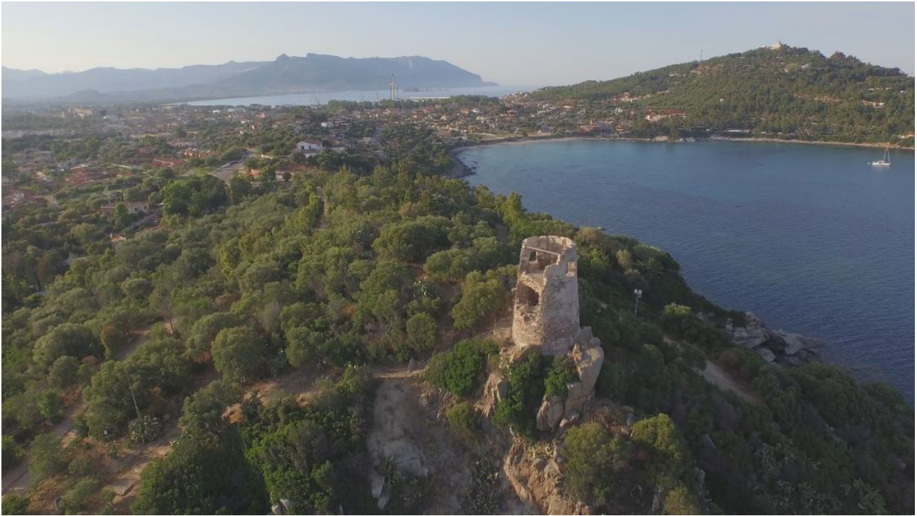
Fig. 9 - La tour de S. Gemiliano (photo Unicity S.p.A.).
