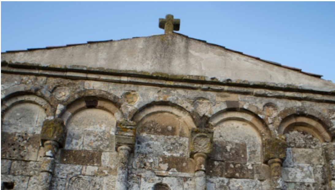
Fig. 1 - Les bassins en céramique du côté occidental de l'église S. Nicola di Trullas (photo Unicity S.p.A.)
