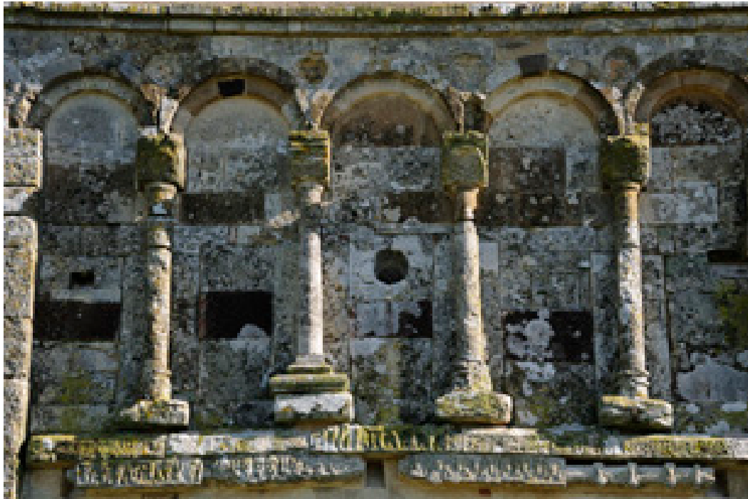
Fig. 2 - Les bassins en céramique du côté occidental de l'église S. Nicola di Trullas (photo Unicity S.p.A.)
