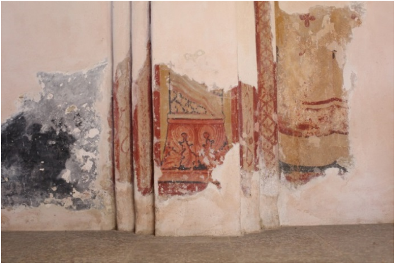
Fig. 4 - Le faux vélarium sur le mur septentrional (photo Unicity S.p.A.).
