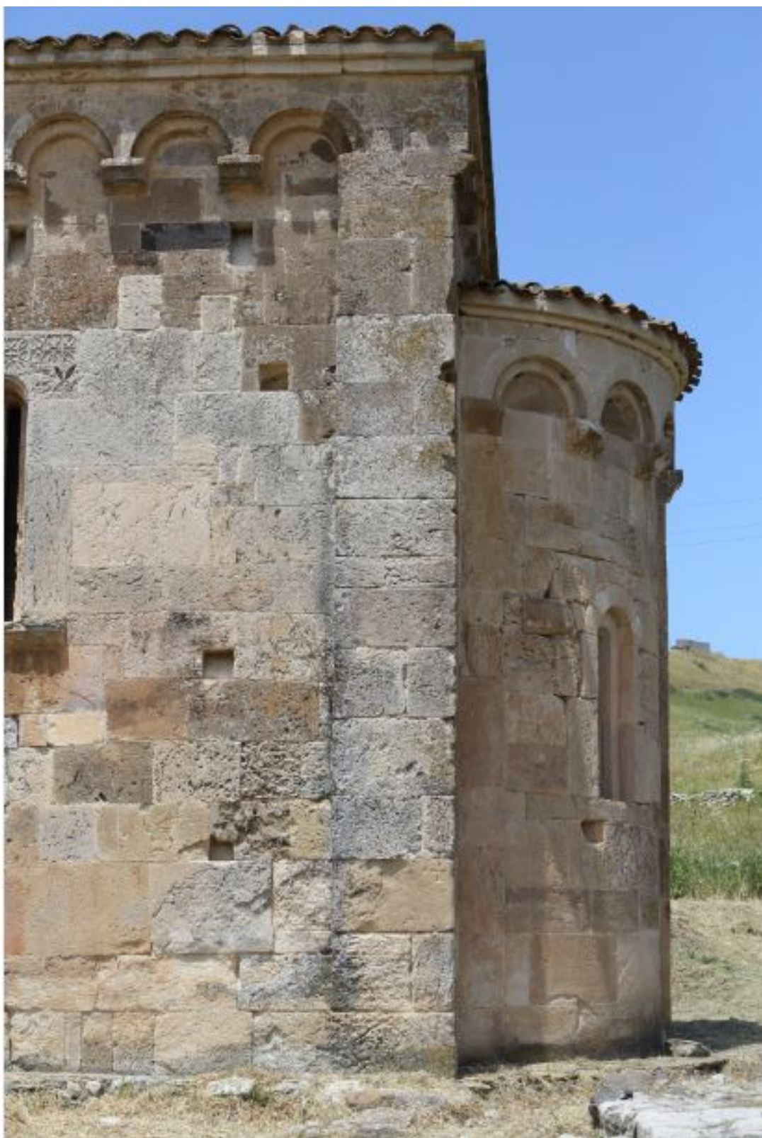
Fig. 2 - L'abside vue du nord-ouest (photo Unicity S.p.A.).
