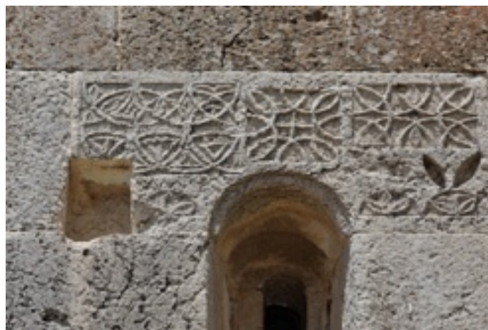
Fig. 4 - Décoration au-dessus de la fenêtre à baie unique de droite du côté sud (photo Unicity S.p.A.).
