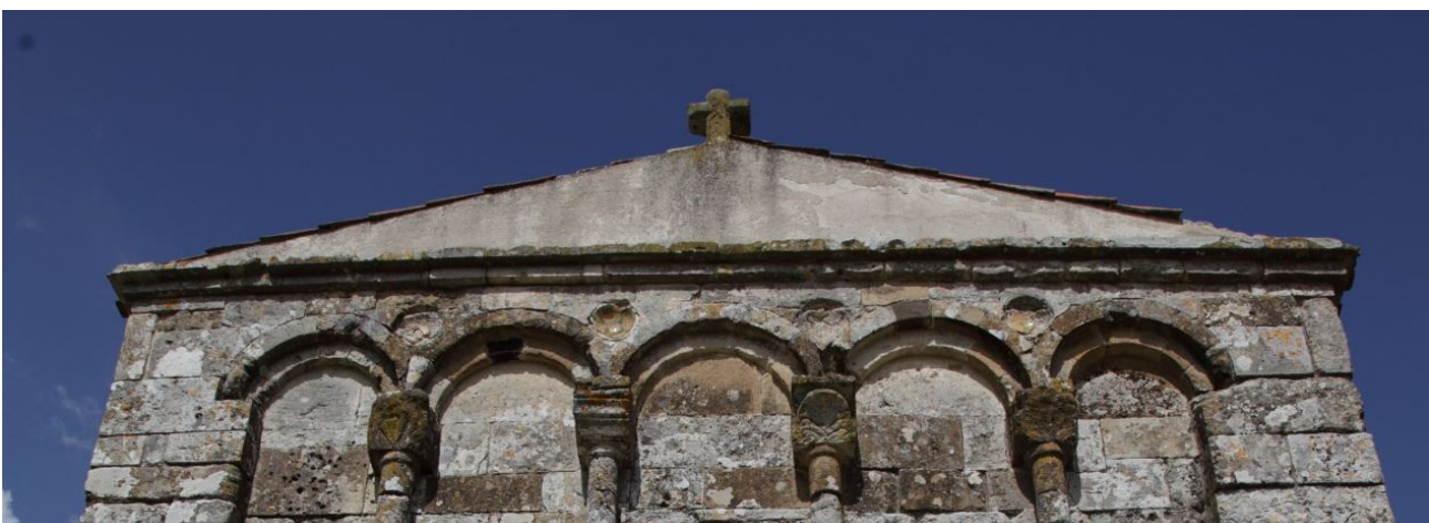
Fig. 3 - Les bassins en céramique dans les voiles des arceaux (photo Unicity S.p.A.).
