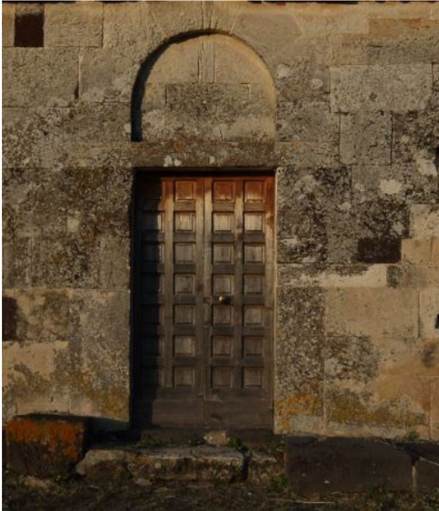
Fig. 4 - Le portail avec l'architrave (photo Unicity S.p.A.)
