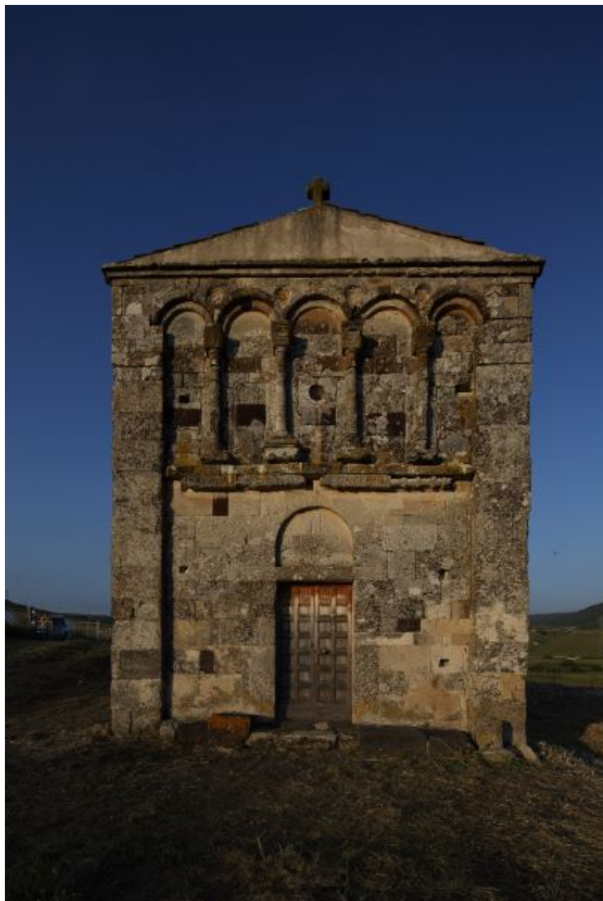
Fig. 1 - La façade de l'église San Nicola di Trullas (photo Unicity S.p.A.).
