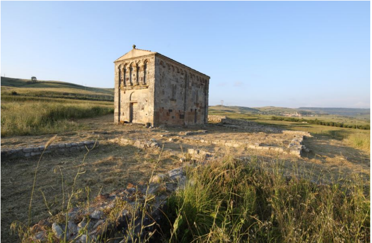
Fig. 2 - L'église San Nicola vue du Sud (photo Unicity S.p.A.).
