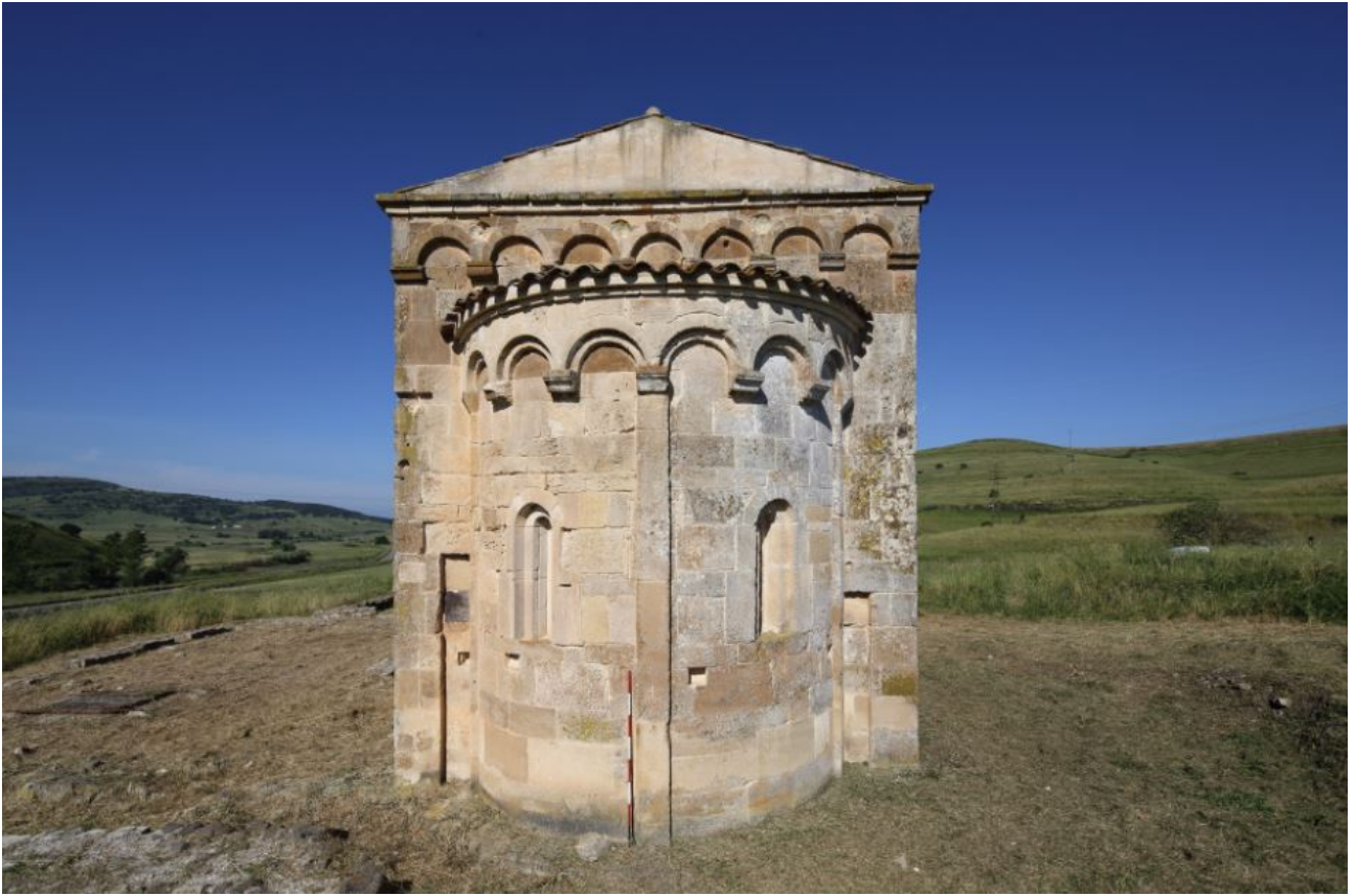
Fig. 4 - L'abside (photo Unicity S.p.A.).
