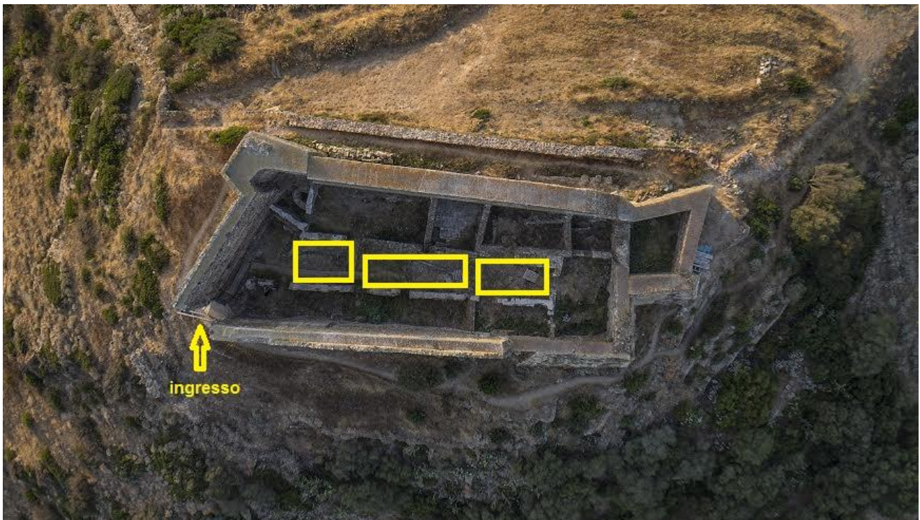
Fig. 2 - Les cours du donjon (réélaboration de M. G. Arru, photo Unicity S.p.A.).
