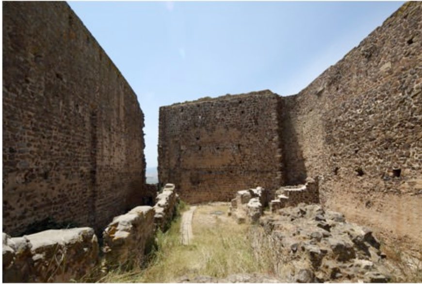
Fig. 13 - L'intérieur du château vu de l'est. Sur les murs on aperçoit les trous des poutres en bois (photo Unicity S.p.A.).
