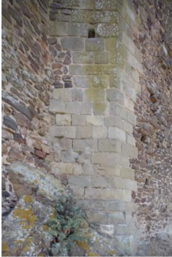
Fig. 14 - Détail de l'ouvrage de maçonnerie (photo Unicity S.p.A.).
