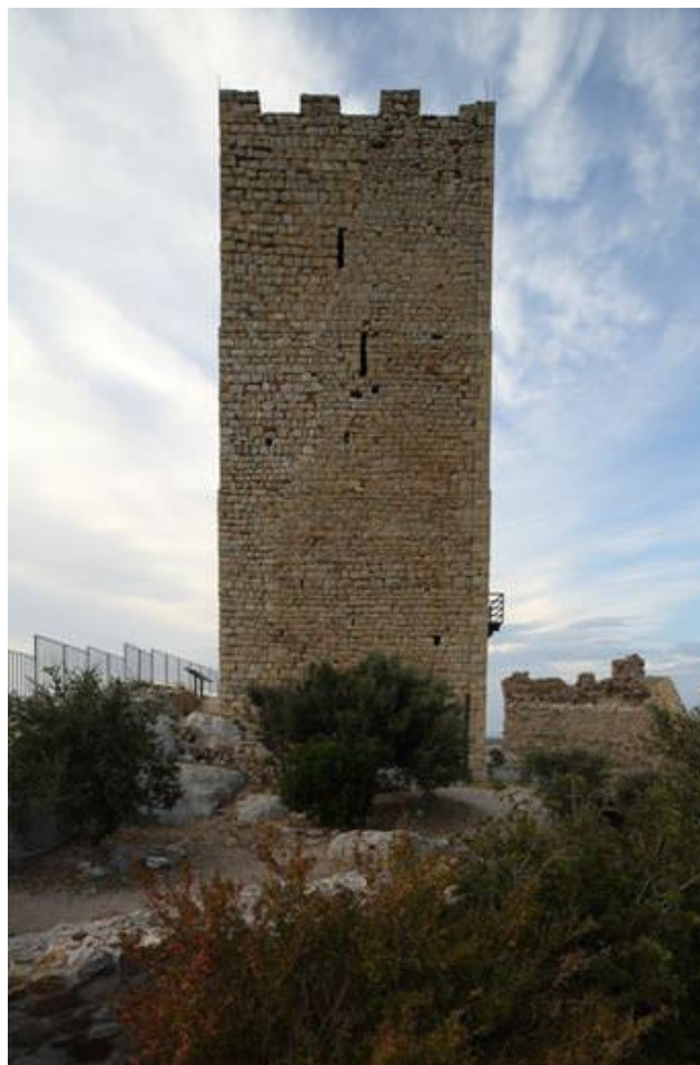
Fig. 3 - La tour du château « de la Fava », Posada
