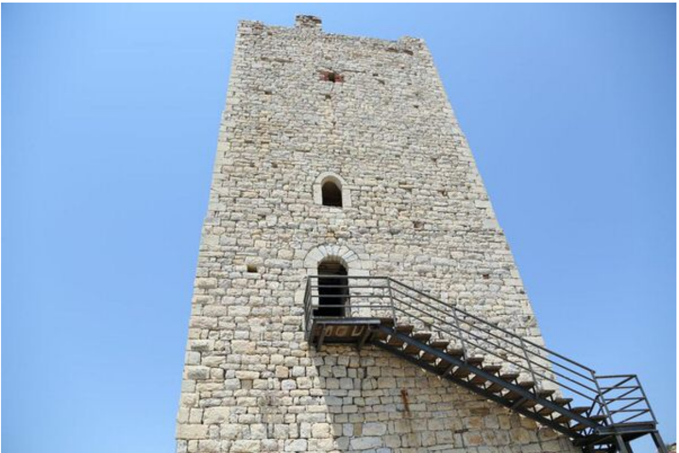
Fig. 5 - Façade principale de la tour ; on observe les ouvertures alignées (photo Unicity S.p.A.).
