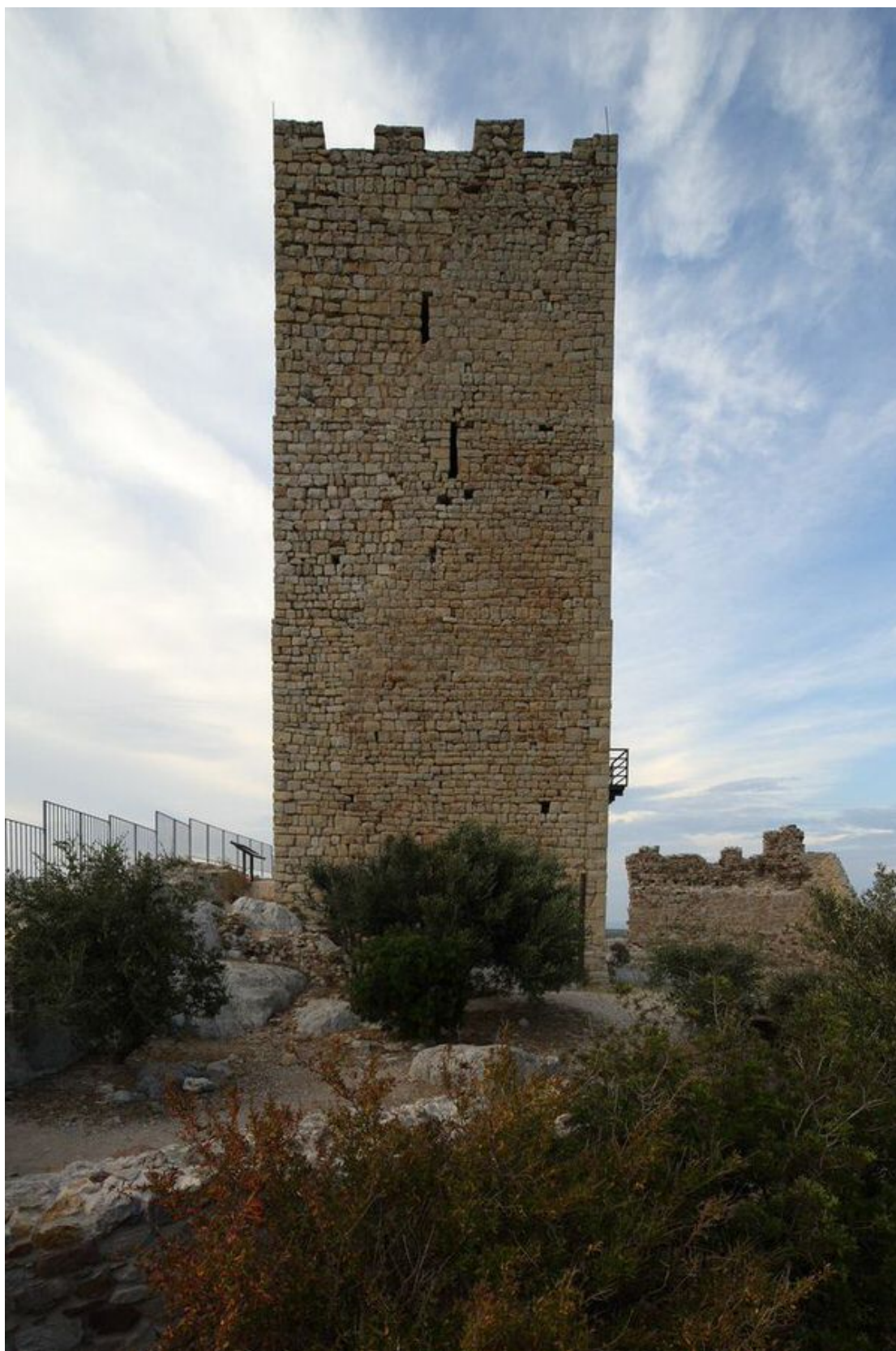
Fig. 7 - Côté sud de la tour, où l'on aperçoit deux meurtrissures (photo Unicity S.p.A.).
