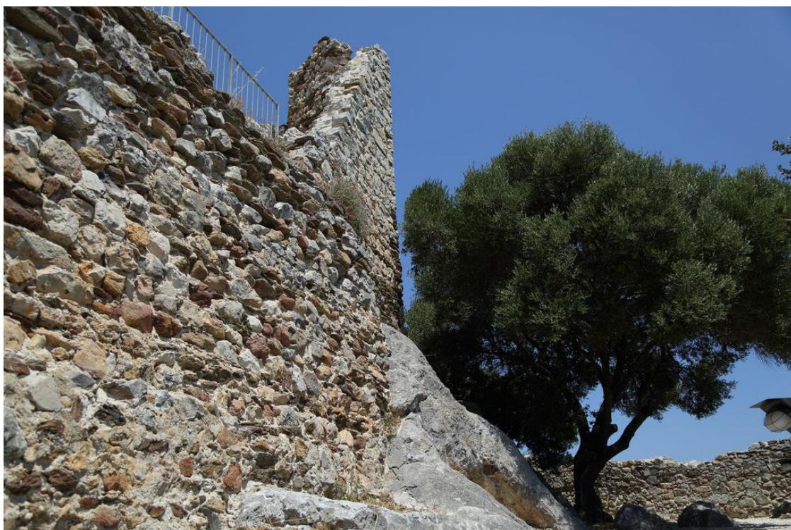
Fig. 4 - Détail des remparts directement ancrés dans le rocher (photo Unicity S.p.A.).
