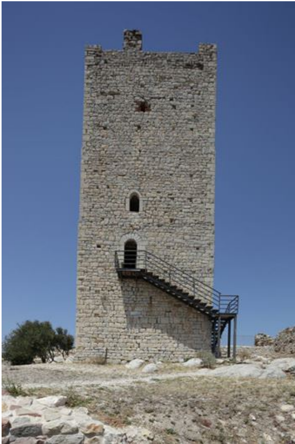
Fig. 4 - La tour du château de la Fava avec l'entrée rehaussée par rapport à la surface de piétement de la place d'armes (photo Unicity S.p.A.).
