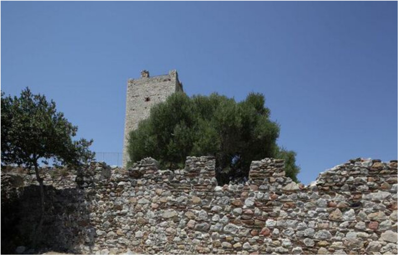
Fig. 3 - Le mur d'enceinte et la tour du château de la Fava (photo Unicity S.p.A.).
