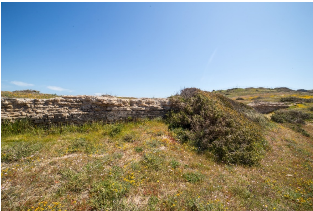
Fig. 3 - Partie de l'aqueduc (photo Unicity S.p.A.)
