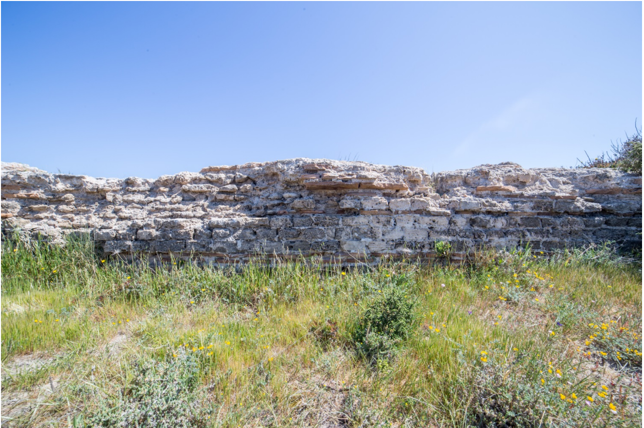
Fig. 4 - La structure de maçonnerie de l'aqueduc (photo Unicity S.p.A.)
