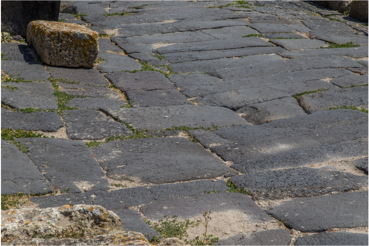
Fig. 5 - Pavage d'une route (photo Unicity S.p.A.)
