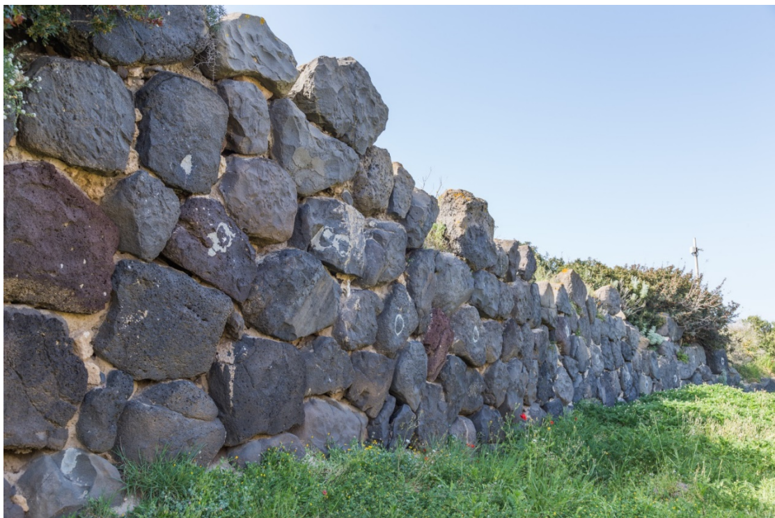
Fig. 3 - Mur de contrescarpe des fortifications (photo Unicity S.p.A.)
